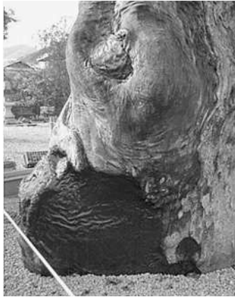
腐朽空洞部位3カ所治療
