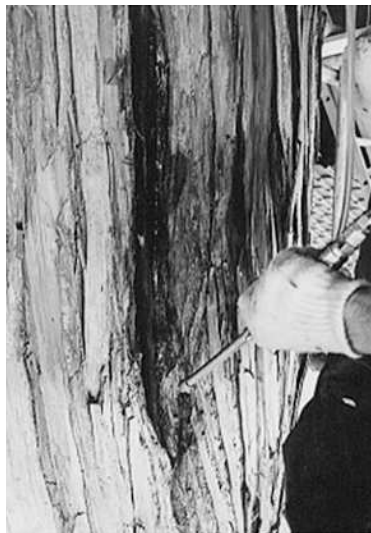
腐朽部の処理
