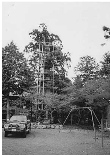
施工前（20mの足場組立）
