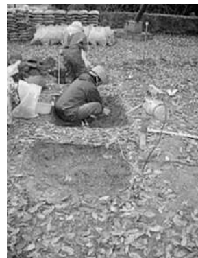
土壌改良掘削
