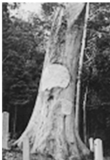
施工後（ウレタン充填）
