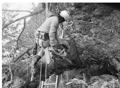
腐朽部の除去
