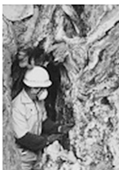
空洞内部の処理
