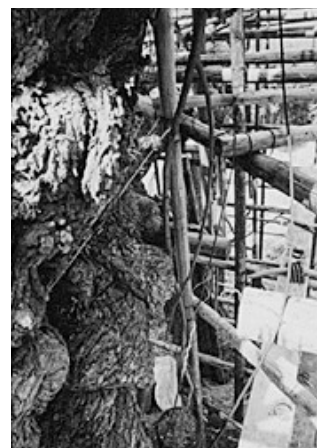
不定根の誘導工事完成
