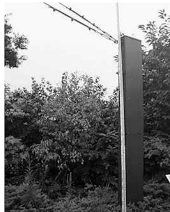
ワイヤー支柱 (H型鋼、被覆ワイヤーΦ12mm)
