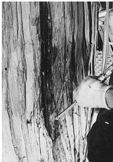
腐朽部の処理
