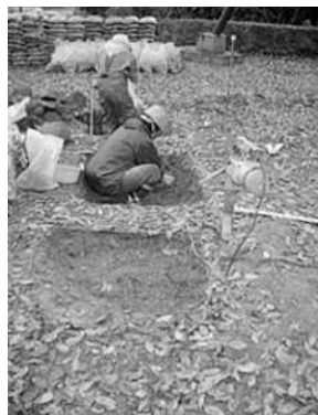
土壌改良掘削
