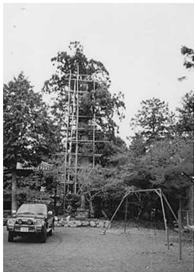
施工前 (20mの足場組立)
