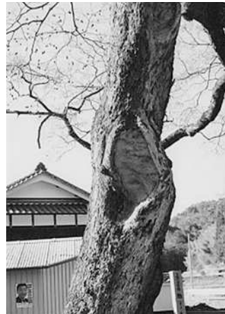
高さ約4m腐朽部の治療完成
