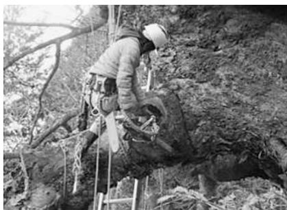
腐朽部の除去
