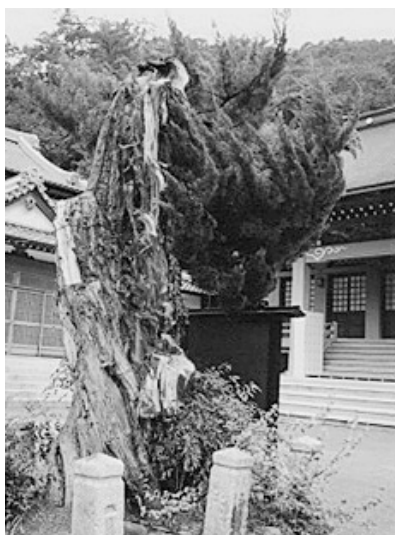
幹割れ (上郡町カイズカイブキ)
